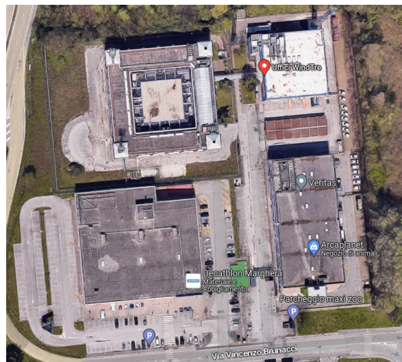
Figura 6-1: vista generale degli uffici
